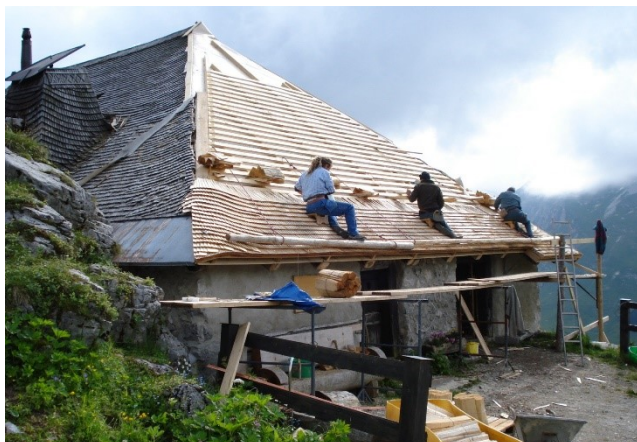
Chalet du Pralet, les tavillonneurs au travail sur un grand toit (© Florence Bays, 2007)
